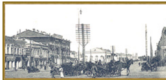
Фрагмент улицы Большой Саратовской от пересечения с Панской улицей (ныне ул. Энгельса) до пересечения с улицей Дворцовой. Доходные дома Зеленковых (ныне ул. Гончарова, №№ 15, 17) Чебоксаровых/Медведевой (№ 19), южный корпус Гостиного двора (утрачен, место здания ЦУМа). Открытка нач. XX в.
